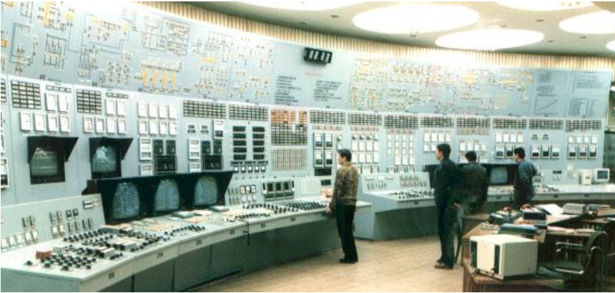
Рис. 8.1. Пулт керування енергоблоком Запорізької АЕС.
