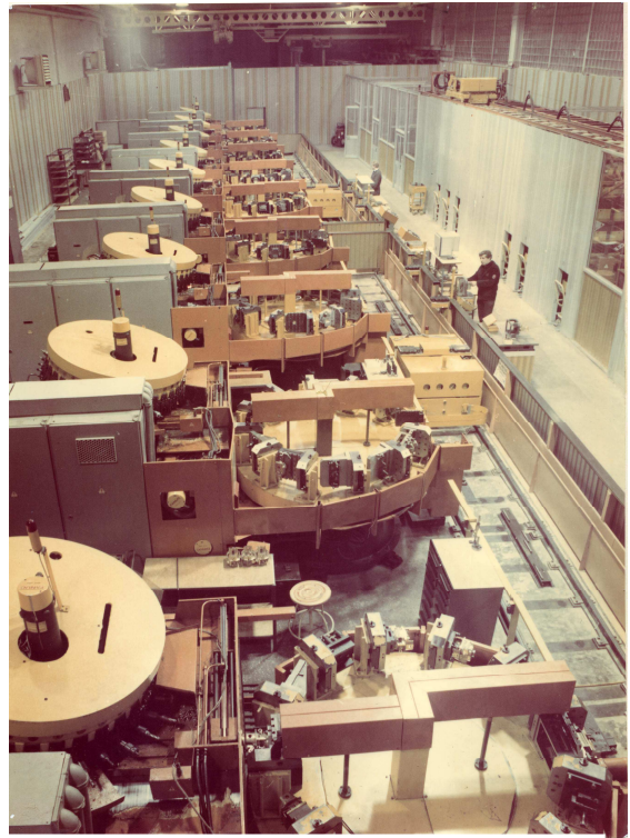
Рис. 4. ГВС на базі 9 верстатів з ЧПУ
