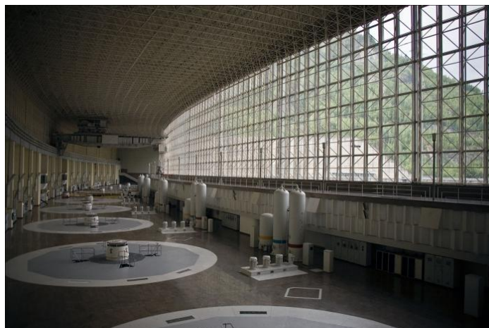
Рис. 2. Машинный зал Саяно-Шушенской ГЭС – вид изнутри до аварии
