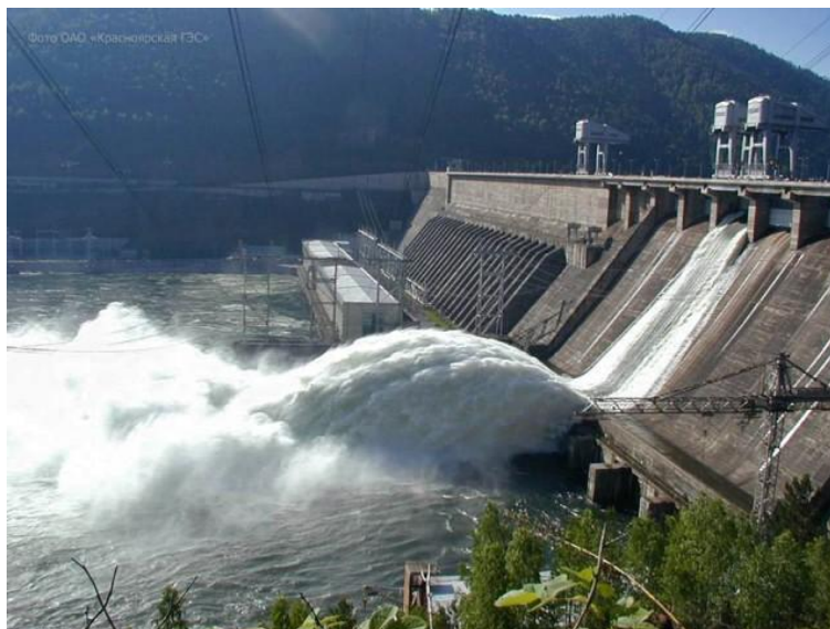
Рис. 1. Саяно-Шушенская ГЭС – вид плотины со стороны нижнего бьефа
