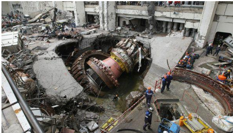
Рис. 3. Машинный зал СШГЭС – вид изнутри после аварии на ГА-2
