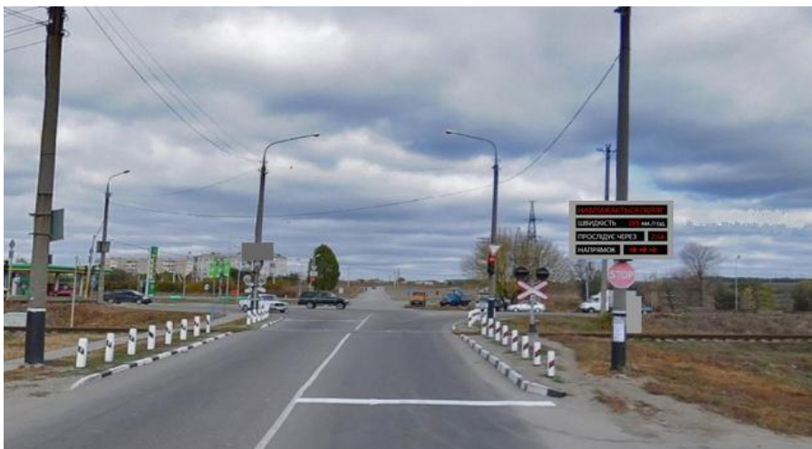
Рисунок 2 – Приклад встановлення КІС «Благовіст» на залізничному переїзді
