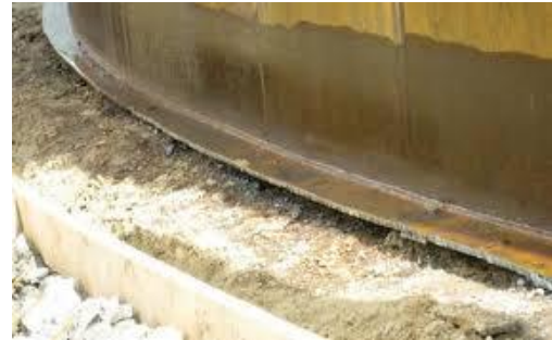
Рисунок 4 – Відхилення зовнішнього контуру днища від горизонтальної площини Рисунок 5 – Зовнішній вид просадки дна СЦР
